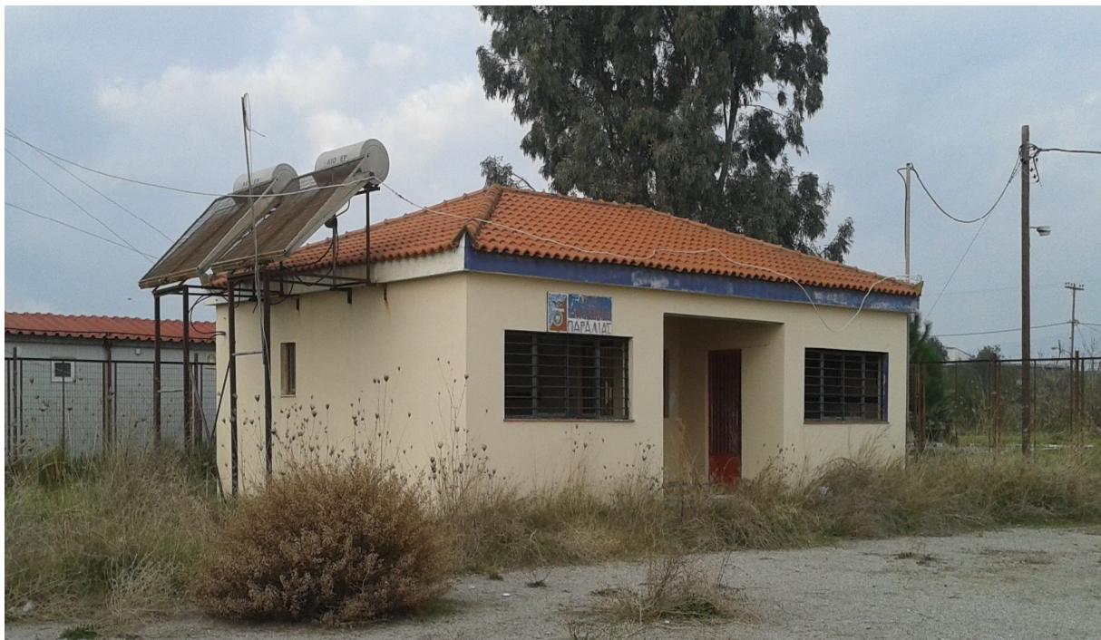
Φωτ. 3. Κτίριο Αποδυτηρίων.
