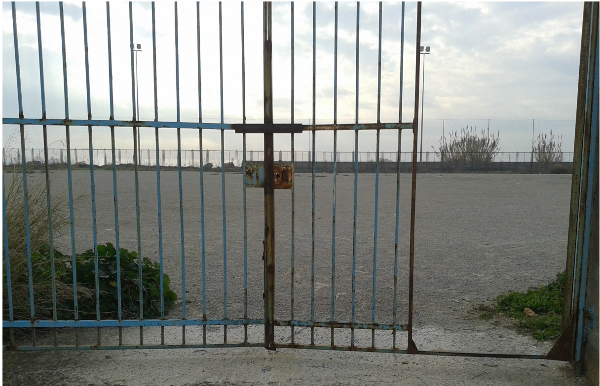
Φωτ. 4. Μεταλλική πόρτα εισόδου.
