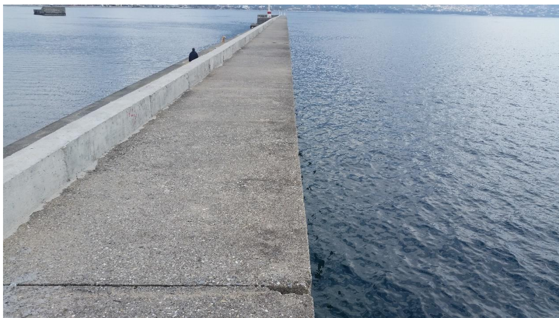
Φωτ.5: Τελευταίο τμήμα προσήνεμου μώλου, με κατακόρυφο μέτωπο
