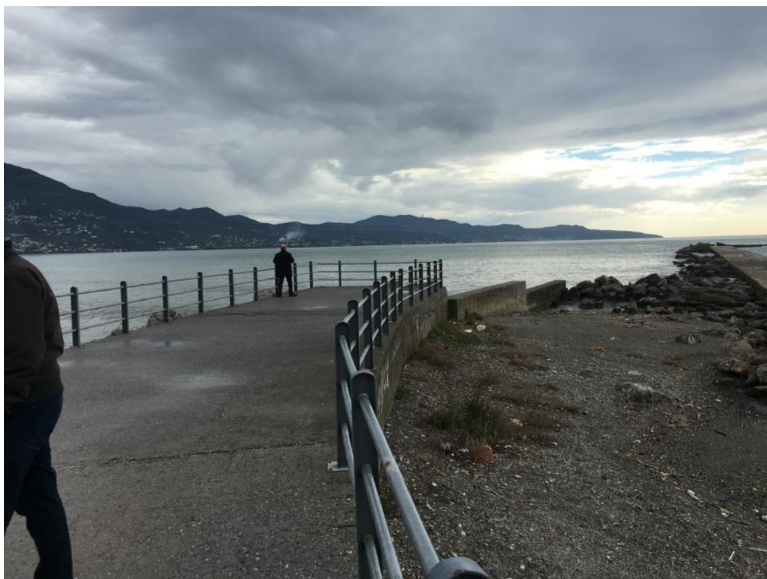
Φωτ. 11: Κανάλι εκτροπής χειμάρρου
