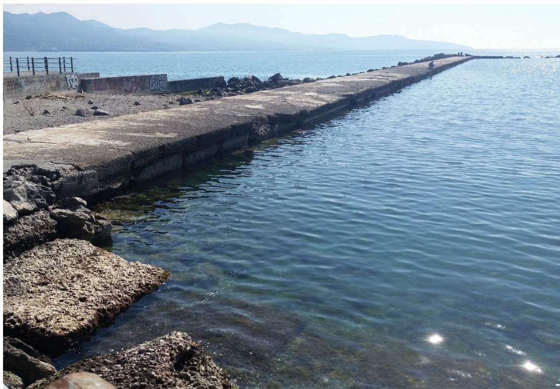
Φωτ. 9: Τεχνητοί ογκόλιθοι θεμελίωσης και ανωδομή από σκυρόδεμα υπήνεμου μώλου
