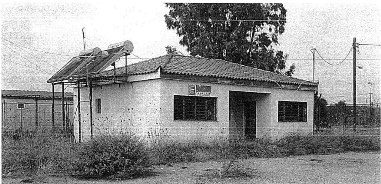
Φωτ. 3. Κτίριο Αποδυτηρίων.
