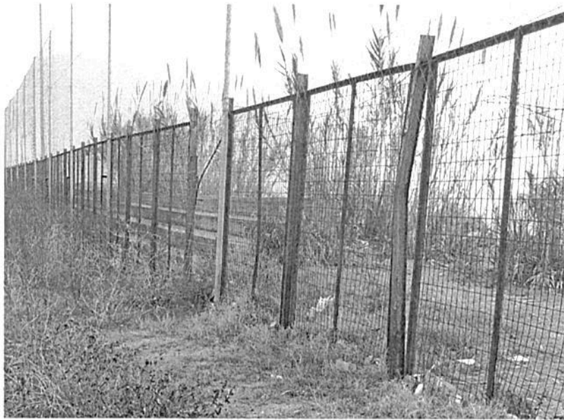
Φωτ. 1 Τμήμα της νότιας περίφραξης.
