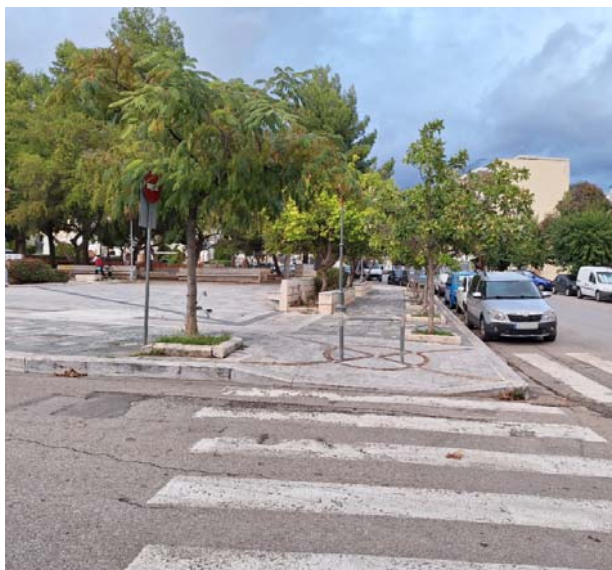
Εικόνα 3.30 Διάβαση Κουμουνδουράκη, πλατεία Φρακόλιμνας
