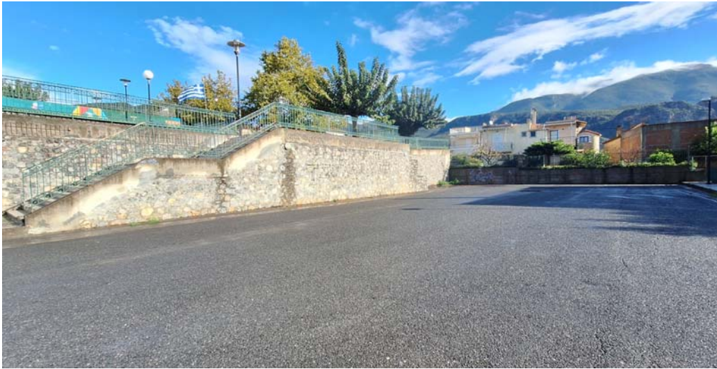
Εικόνα 3.48 Χώρος στάθμευσης πλατείας Αρφαρών
