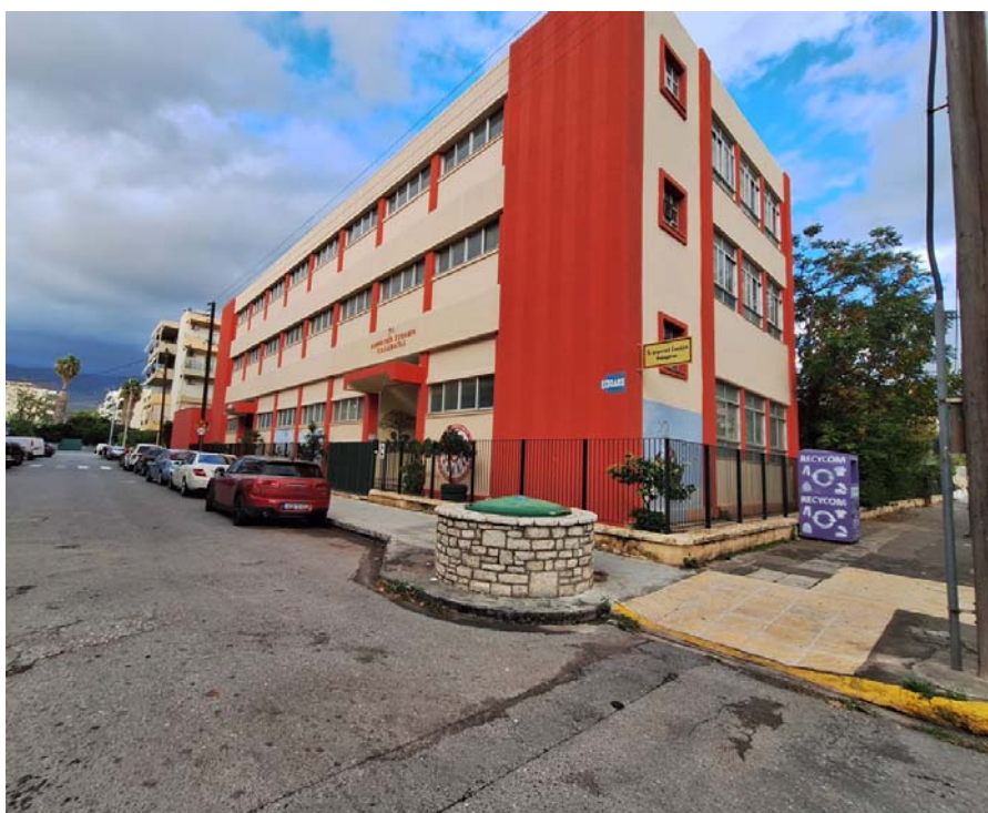
Εικόνα 3.16 Άποψη του 7 ου Δημοτικού Σχολείου
